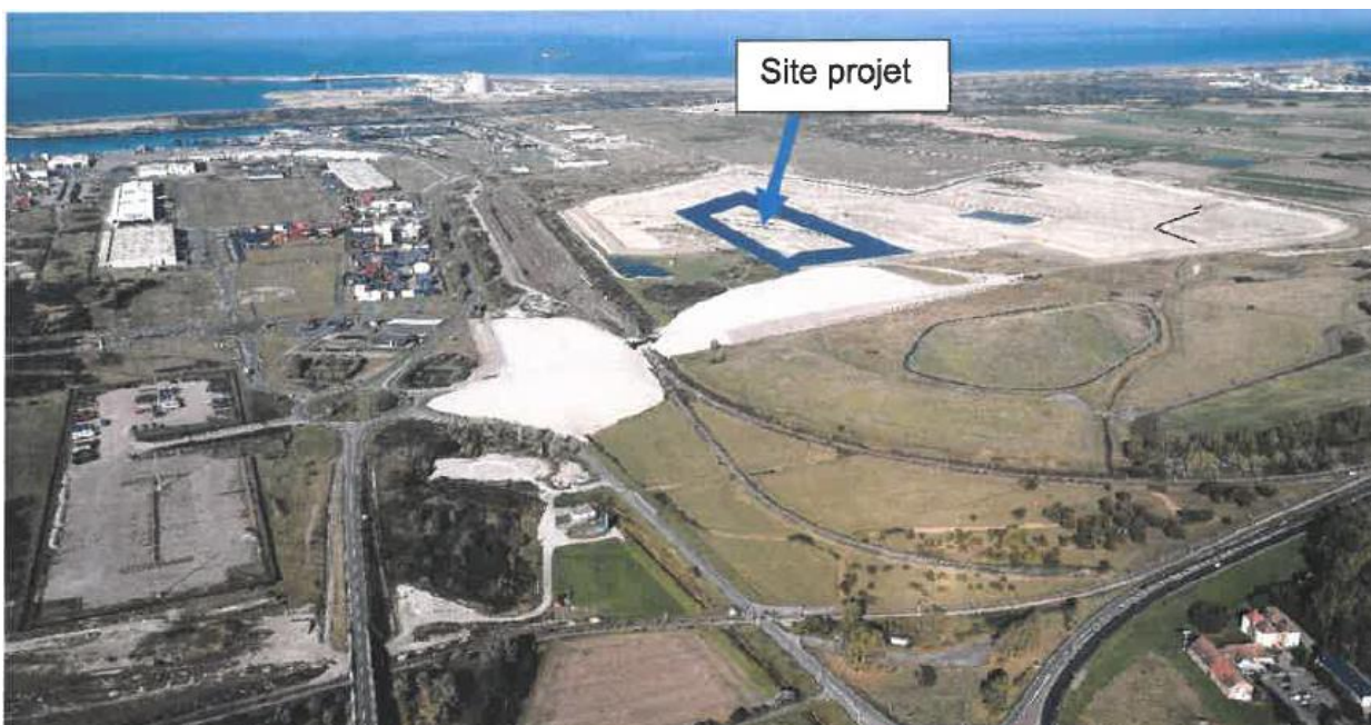
Figure 3 : photographie du site -octobre 2018 (source : dossier)
